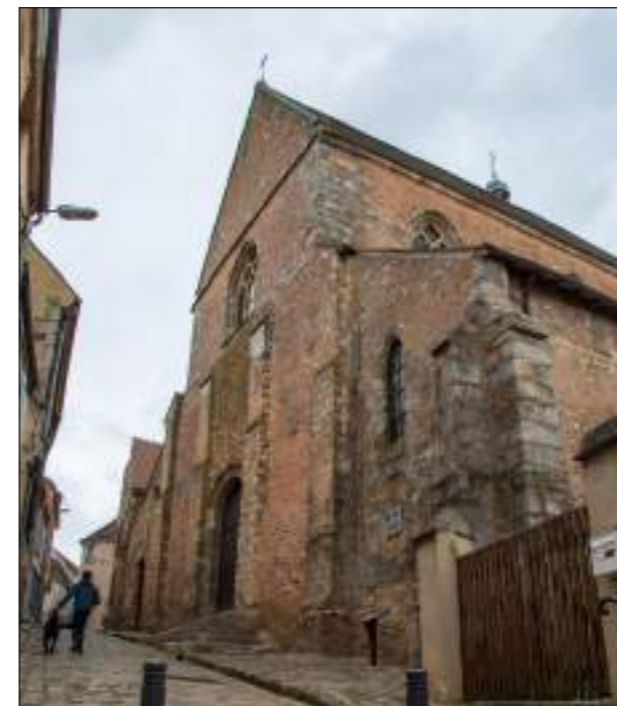
Photographie 1. Église paroissiale Saint-Pierre (Epernon)
